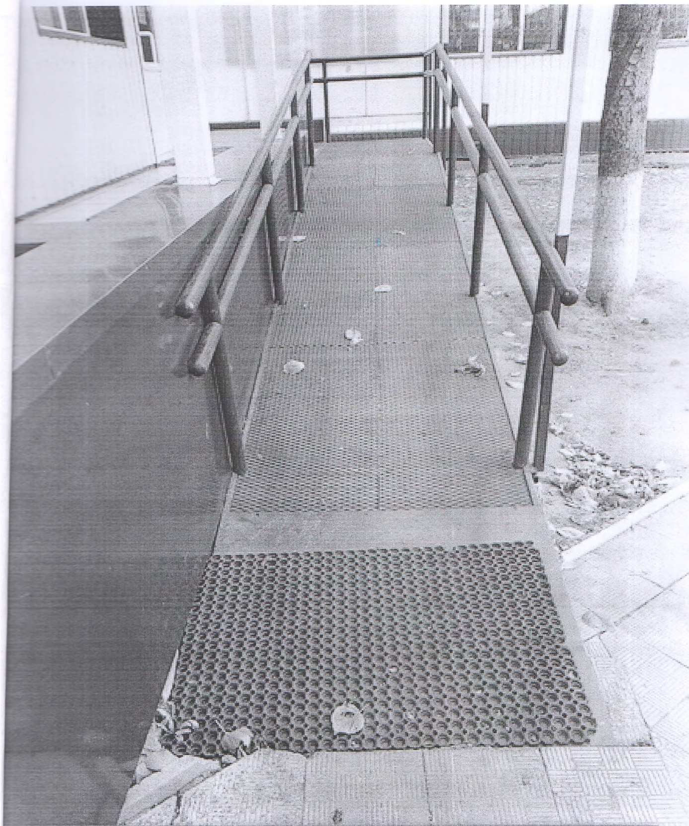
Пандус на вході в будівлю коледжу
